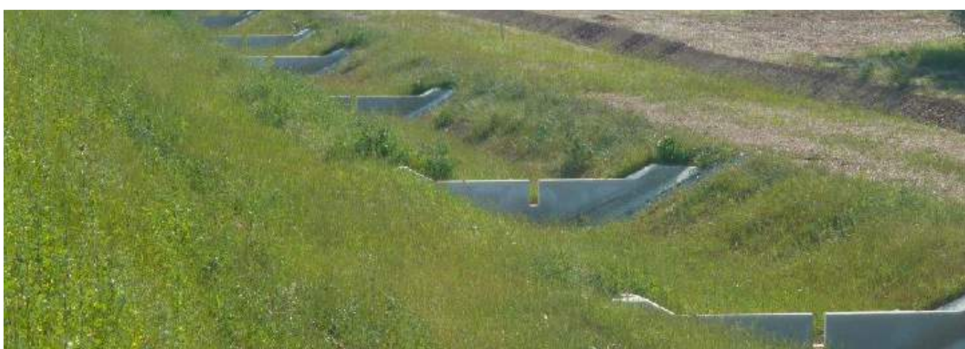
Principe de noue avec système de barrages.
